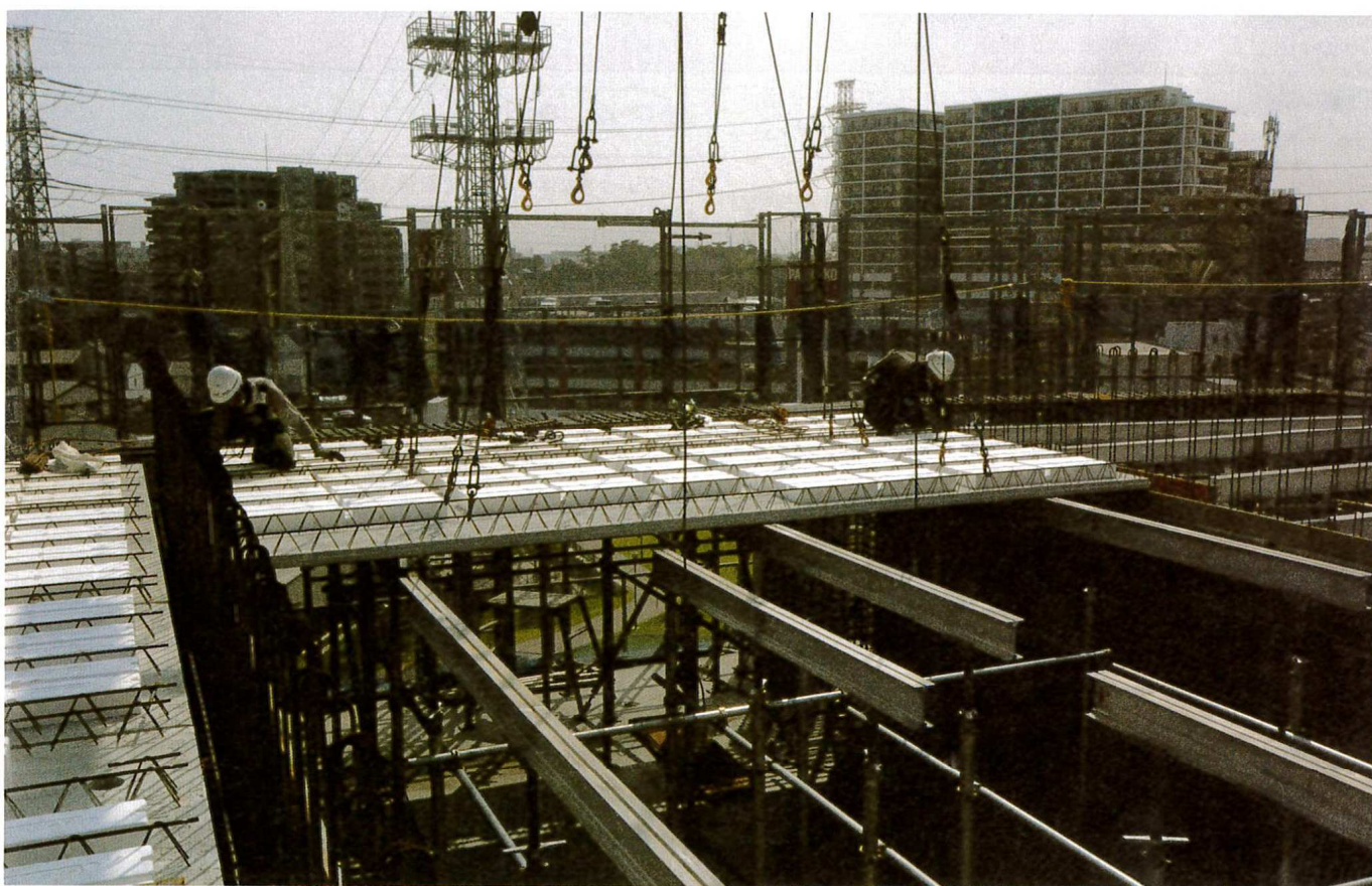
PCaは生コンではなく構造体コンクリートなので、指定建築材料の枠外とされる（写真：本誌）
