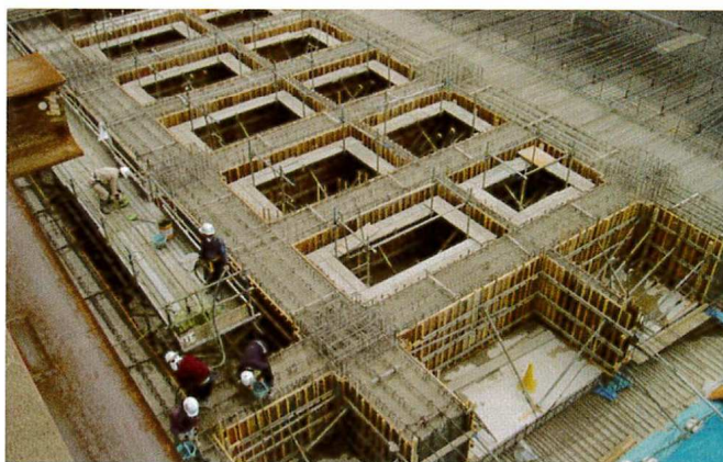
写真1 大規模な基礎梁に注意
