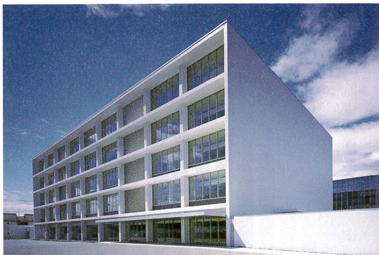
写真2 大面積の妻壁を目地なしで施工
