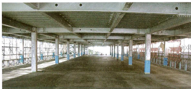
写真3 ひび割れリスクのあるデッキ床スラブに導入
