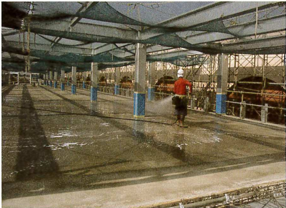
写真4 養生期間は十分に確保 床スラブを打設し終わったあとは、散水など湿潤養生を徹底する必要がある
