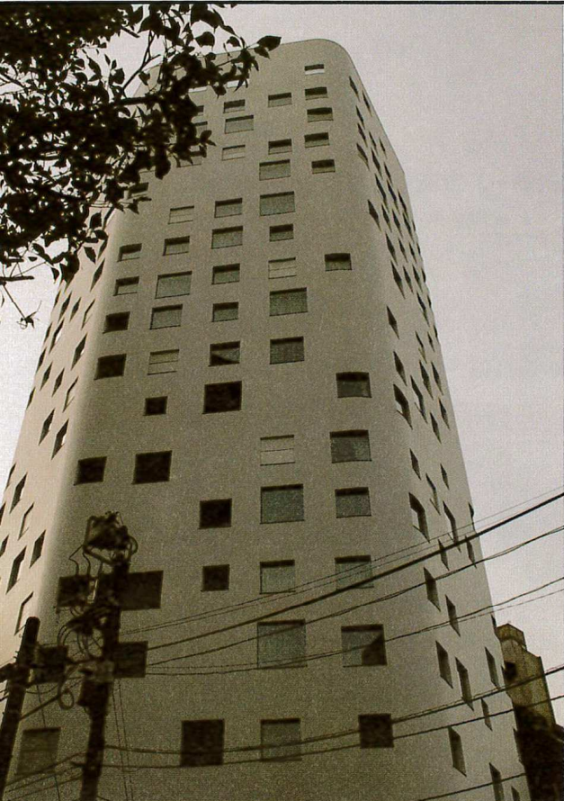
写真2 大面積の妻壁を目地なしで施工
