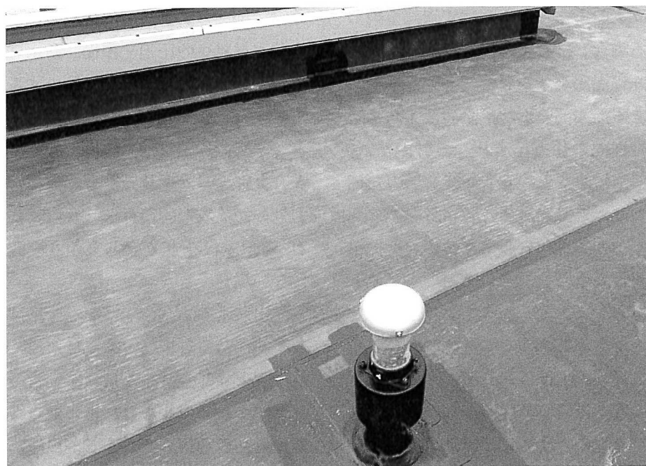
④露出防水配管立ち上がり
