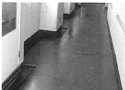
⑩開放廊下のウレタン系塗膜防水
