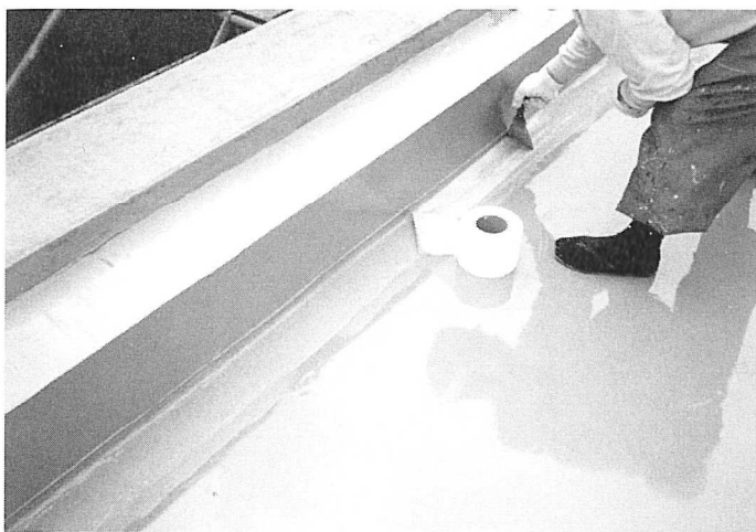
③ウレタン塗膜防水補強布張り
