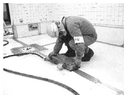
⑦平場溶接部真空検査
