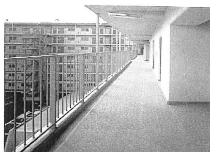
⑪開放廊下のウレタン系塗膜防水＋長尺シート
