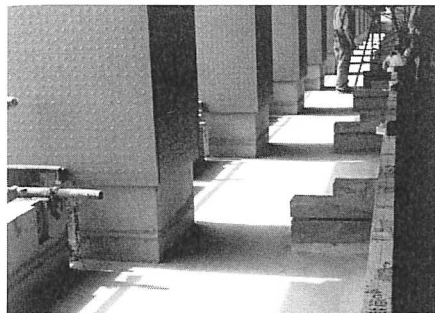
④オフィスの回廊状のバルコニー
