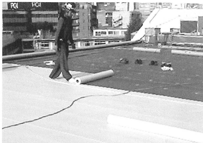
⑧塩ビ系シート防水機械固定のシート張付け
