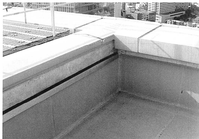
⑤露出防水立ち上がり露出。床・立ち上がりとも露出シート防水。笠木は、コンクリートあごにアルミ笠木を取り付けている
