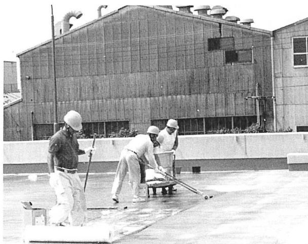
④FRPライニング
