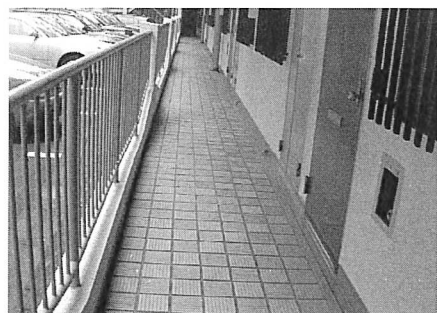
⑨開放廊下の状況
