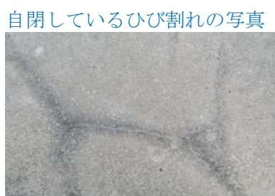
表面が圧縮により弾け断面欠損しているが内部は自閉しているひび割れ
